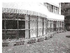
後日ネット張りを 行い完成しました！
